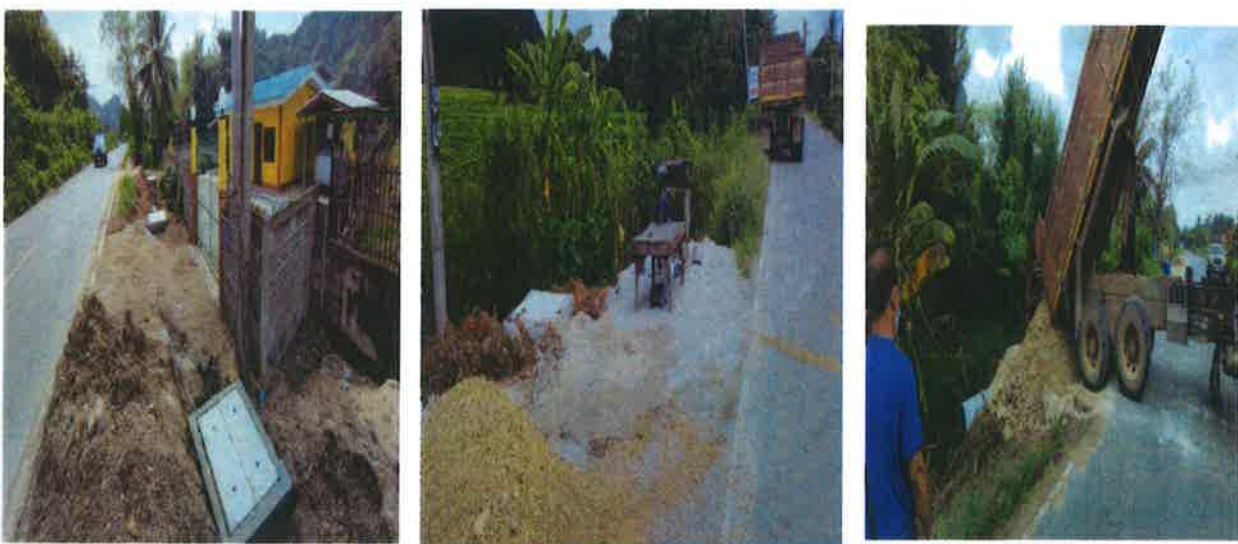
ภาพหลังดำเนินการ
